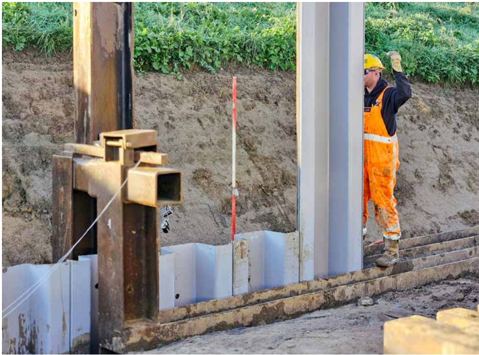
Voor de dijkversterking bij Arcen leverde het bedrijf de Prolock Epsilon kunststof schermen. (Beeld: Profextru)
