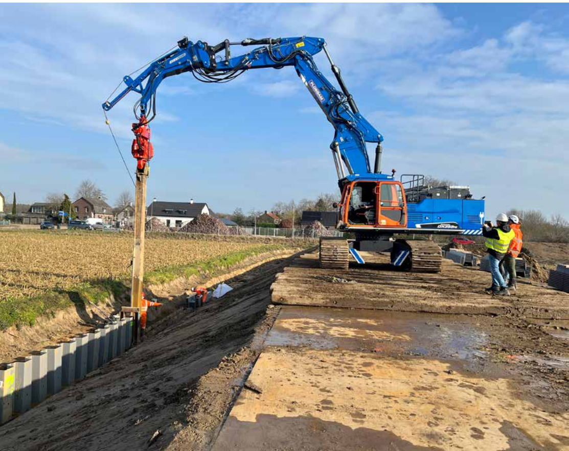
De schermen kunnen met lichter materieel worden aangebracht dankzij het relatief lage gewicht. (Beeld: Profextru)
